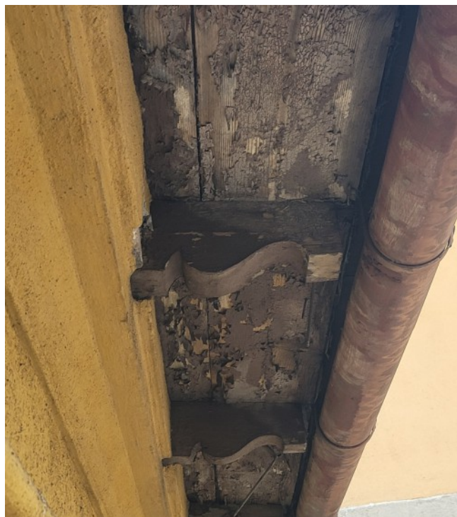
Fot. Zachowane wszystkie (z wyjątkiem jednej) rzeźbione zakończenia krokwi
