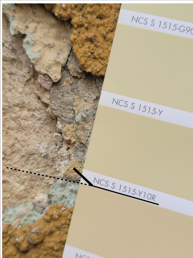
Fot. Uproszczona stratygrafia elewacji.
