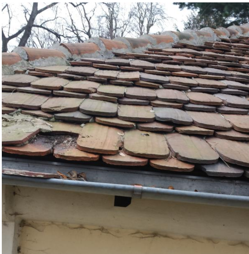
Fot,Dachówka od strony frontowej
