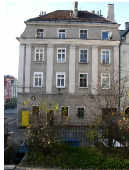
WIDOK OD STRONY PODWÓRZA
