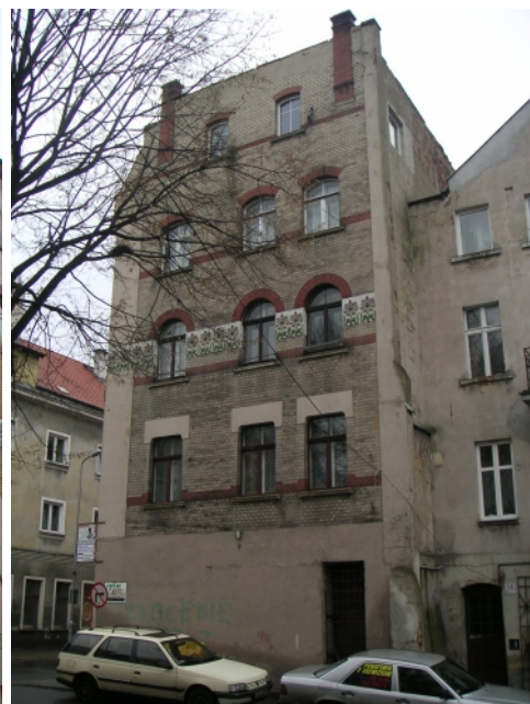
WIDOK OD STRONY PODWÓRZA
